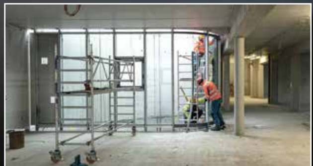
Sanierung der Ernst Keil Grundschule Höchberg – Fenster und Türen
