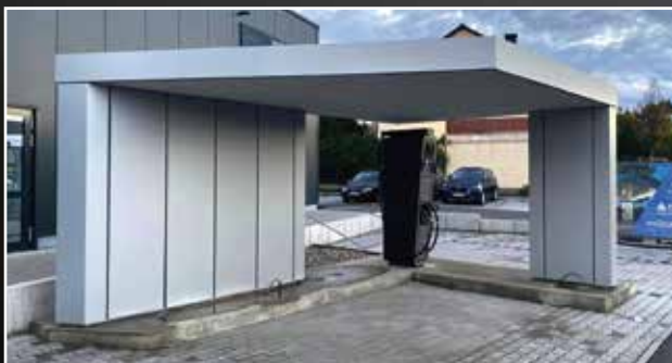
Dachkonstruktion der Schnellladestation K.A.R.L in Höchberg
